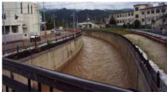
図 5 洗心橋からみる新湊川-写真奥が上流
