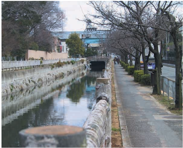
土居川導水管口（南宗寺前）
