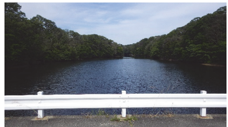
写真 2 M 池を堤体中央より望む
