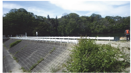
写真 1 M 池堤体を下流側より望む
