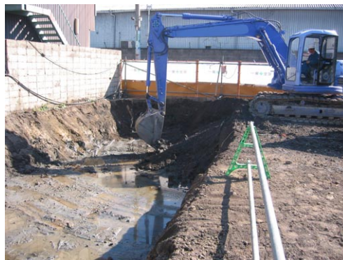
図2 汚染土壌の掘削除去
