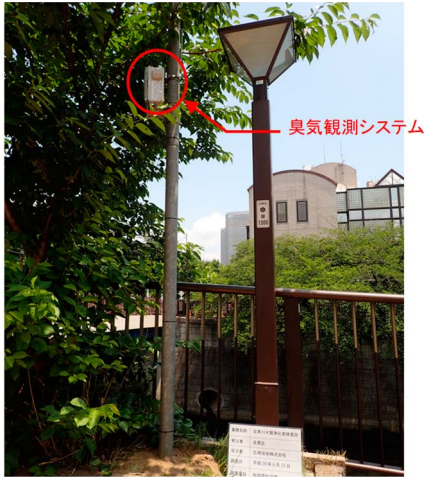
図 2 臭気観測システムの設置状況
